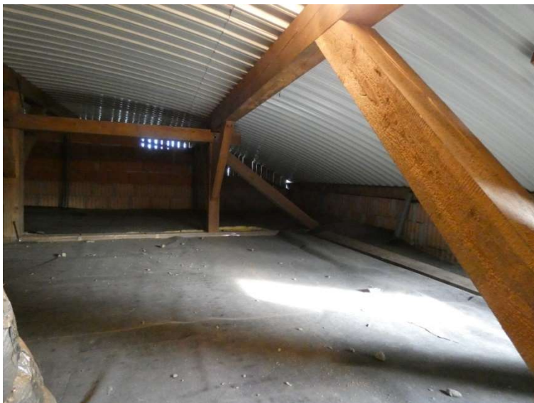
Foto 1: Prostor pod kovovou krytinou není tepelně izolován.
